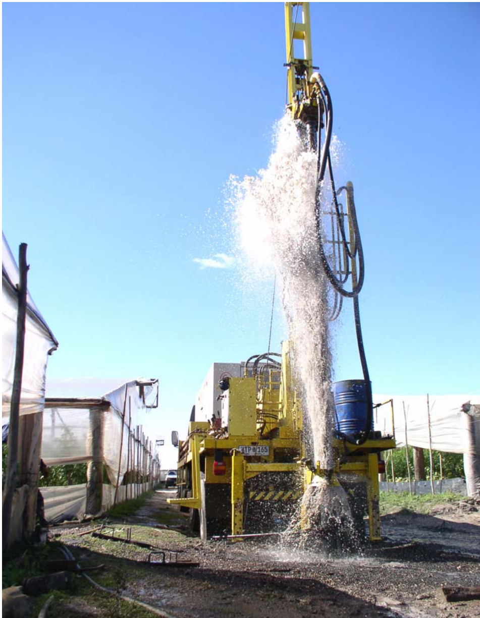
Perforación en acuífero basáltico. Salto. Uruguay. (Fuente: R Silva)
